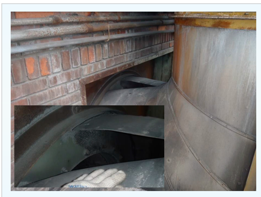
Figura 13: Duto antes do ventilador de exaustão da capota.
